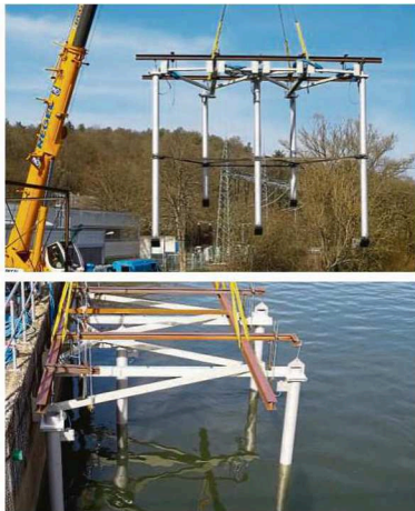
Strom aus Wasserkraft: Eine Fischeicheuanlage im Affolderner See (Fotos rechts) soll Fische vor dem Tod in den Kraftwerksturbinen bewahren; links die Rohrbanham am Pumpspeicherkraftwerk Waldeck 1.
